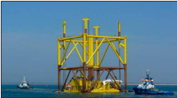
Şekil 6.14. DRES şalt sahası temel nakliye.
