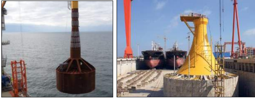
Şekil 5.30. Vakumlu kova keson temeli.
