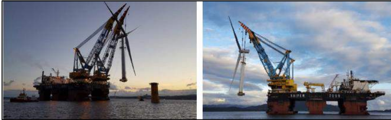
Şekil 10.59. Blyth Scotland DRES DRT tek parça montajı.
