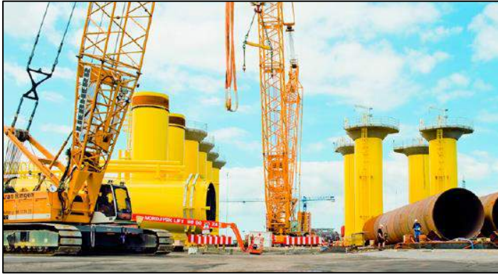
Şekil 6.9. Limanda tek kazıklı temel depolanması.
