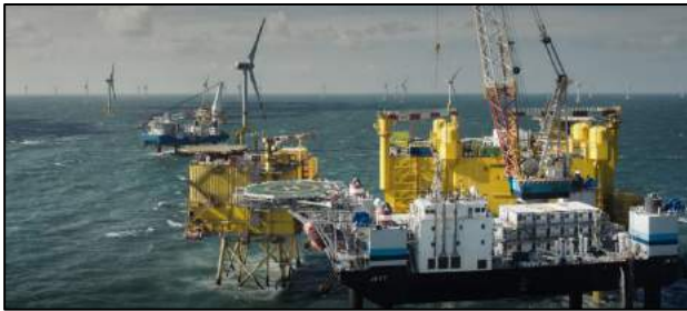
Şekil 9.24. Borwin Beta DRES şalt sahası montajı.
