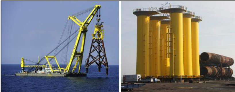
Şekil 9.16. Bladt Industries Baltic 2 DRES ve London Array DRT temelleri.
