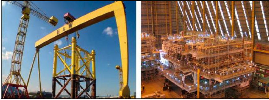
Şekil 6.13. DRES şalt sahası alt taban ve tepe kısmı.
