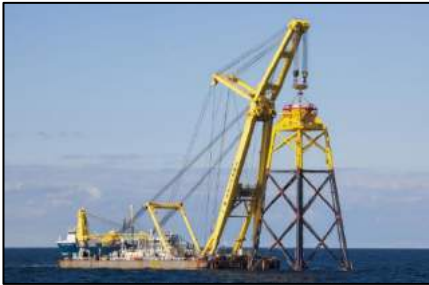
Şekil 10.47. Wikinger DRES kafes temel montajı.
