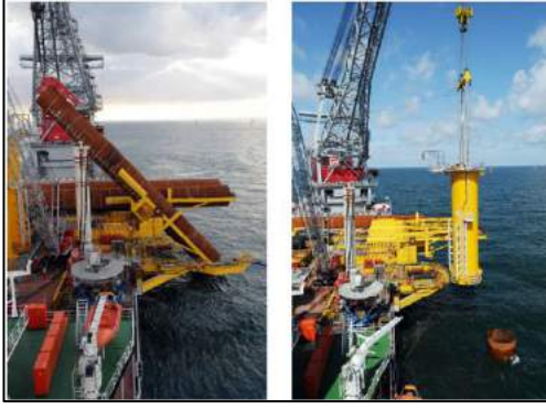
Şekil 10.45. Tek kazıklı temel ve geçiş parçası montajı.
