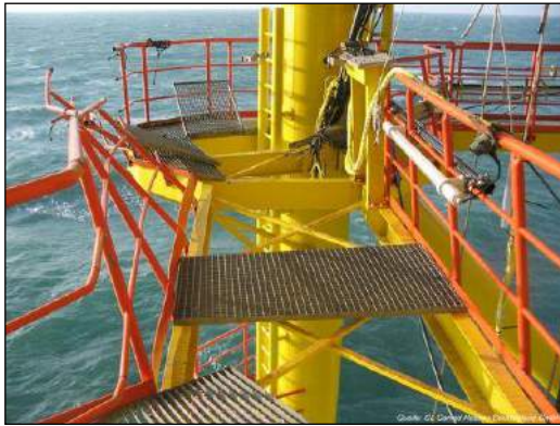
Şekil 4.26. Siklon Britta hasarı.
