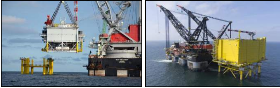
Şekil 10.62. DRES denizüstü şalt sahası temel üzerine indirilmesi.
