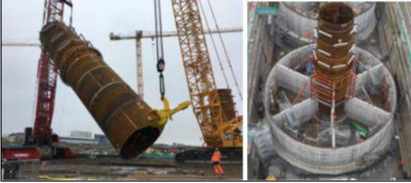
Şekil 10.42. Gravity base DRT temeli.
