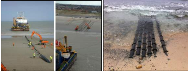
Şekil 10.73. Yeraltıdan TM'ye YG kablo çekilmesi.
