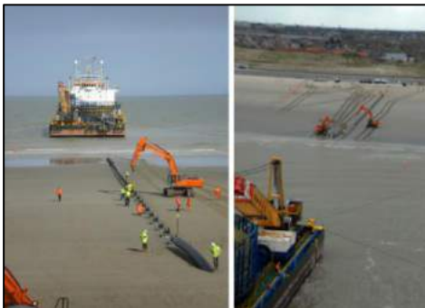
Şekil 11.24. Thornton Bank DRES karaüstü ENH kablo çekilmesi.
