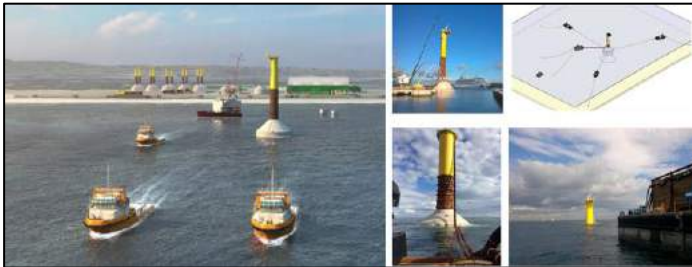
Şekil 10.17. Ağırılık temel gemi ve tug-boatlar ile deniz üzerinde yüzdürülme.
