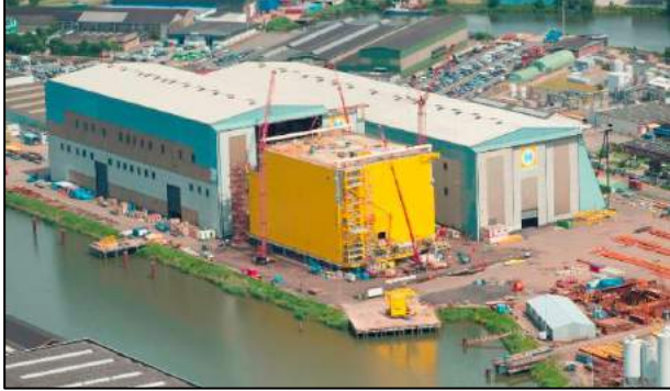
Şekil 6.3. Hollanda Zwijndrecht limanında bulunan denizüstü şalt sahası üretim tesisi.
