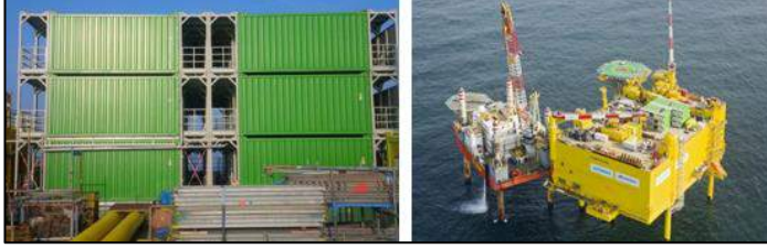
Şekil 9.25. Helwin Alpha DRES şalt sahası konteyneri.
