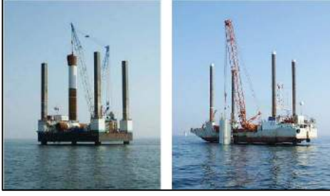
Şekil 11.43. Horns Rev DRES türbin montajı.
