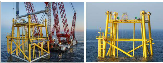
Şekil 10.48. Gemini DRES kafes temel montajı ve bitmiş hali.
