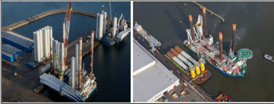
Şekil 10.6. Blyth DRES projesi kule nakliyeyle hazır hale getirilmesi.
