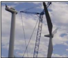
Şekil 10.56. Rotor star yöntemi ile montaj.
