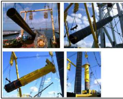
Şekil 11.15. Temel ve geçiş parçasının gemiye yüklenmesi.
