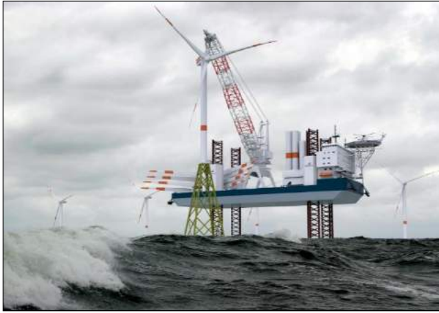
Şekil 7.14. Jack up gemi vinci ile montaj.
