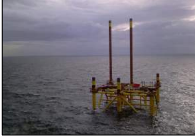
Şekil 10.61. DRES denizüstü şalt sahası denize çakılması.
