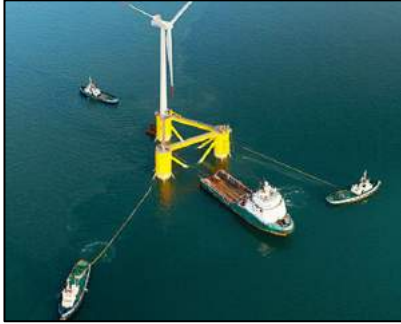
Şekil 10.27. Yüzer temelin gemi ve tugboat ile çekilerek nakliyesi.
