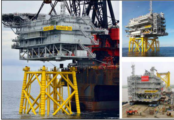
Şekil 9.38. Gode Wind, Walney 03 ve Burbo Bank DRES şalt sahaları.
