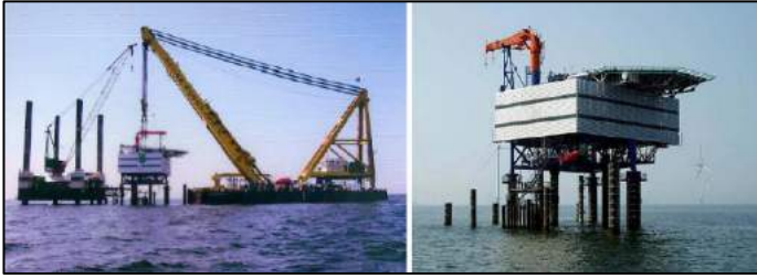
Şekil 11.44. Horns Rev DRES şalt sahası montajı.
