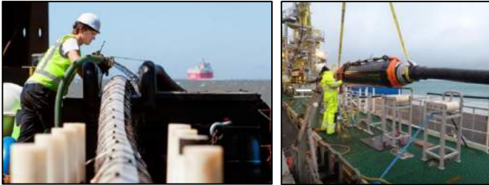
Şekil 11.45. Horns Rev DRES denizaltı kablo serilmesi.
