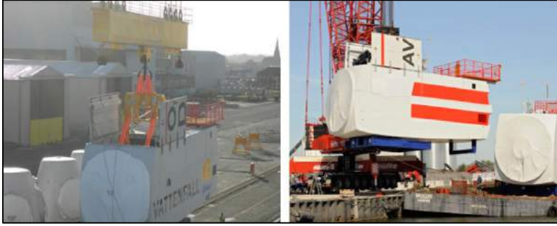
Şekil 6.8. Limanda nasele yükleme işlemleri.
