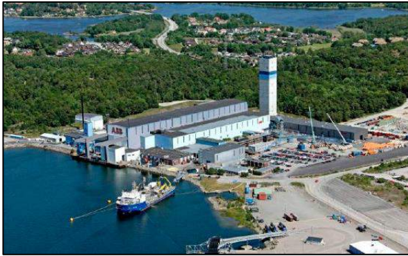
Şekil 6.17. Limanda DRES ENH kablo üretim tesisi.
