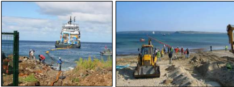
Şekil 10.72. Denizüstü şalt sahası-kara arasındaki YG kablolama.
