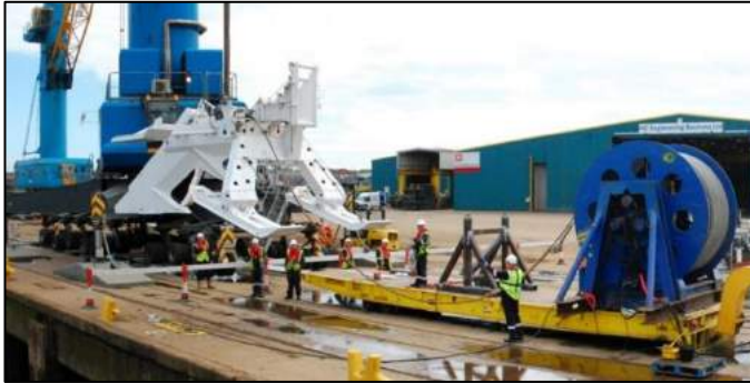
Şekil 10.71. Özel gemi ile YG kablonun denizaltına serilmesi.
