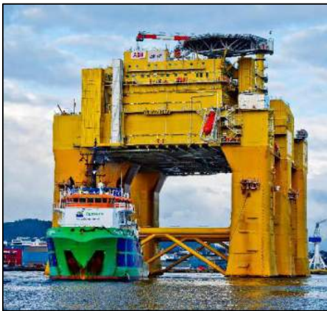
Şekil 10.32. DRES denizüstü şalt sahası gemi ile yüzdürülerek nakliye işlemi.
