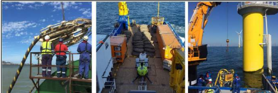
Şekil 9.29. Thanet DRES denizaltı kablo montajı.
