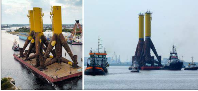
Şekil 10.20. Grup kazıklı temel gemi üzerinde nakliye.
