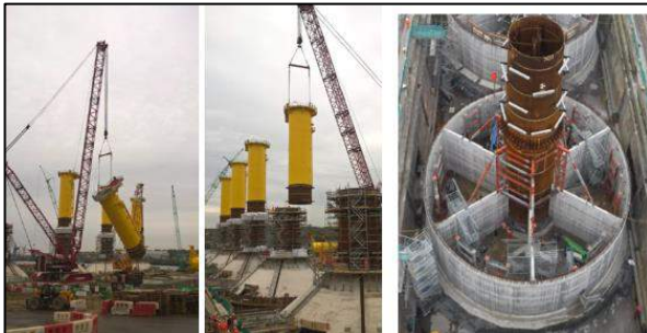
Şekil 10.35. DRT kule ve geçiş parçası limanda ön montaj işlemleri.
