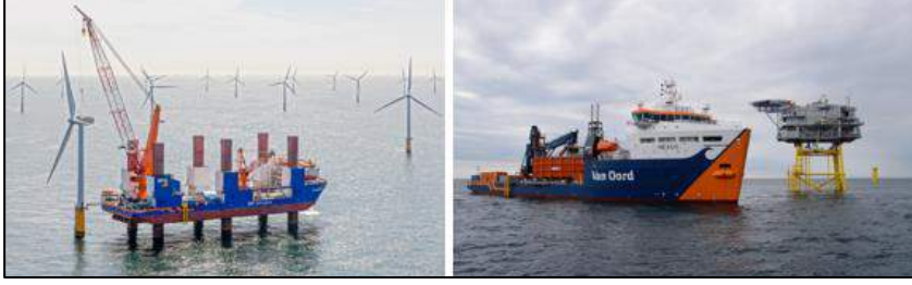
Şekil 9.27. Arkona DRES türbin ve şalt sahası montajı.
