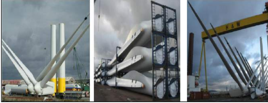
Şekil 10.33. DRT limanda ön montaj işlemleri.
