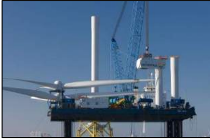
Şekil 10.58. Ormonde DRES nasel montajı.
