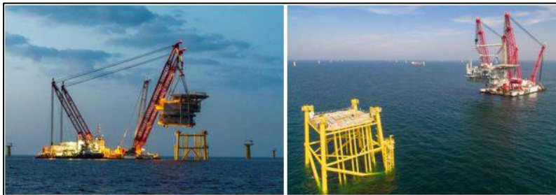
Şekil 9.40. Amrumbank West 1 ve Gemini DRES şalt sahası montajı.
