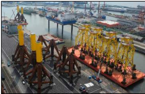
Şekil 6.2. Bremerhaven limanında bulunan temel üretim tesisi.
