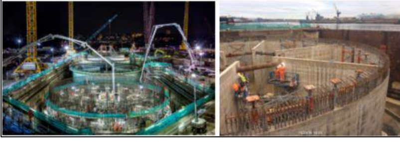
Şekil 10.41. Gravity base DRT slipform duvar eklenmesi.
