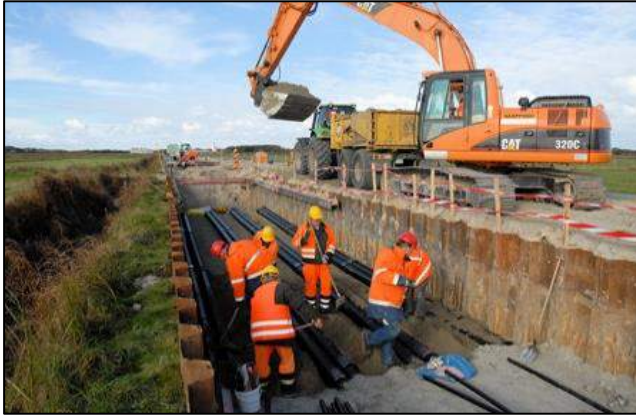
Şekil 10.74. TM'ye YG kablo çekilmesi.
