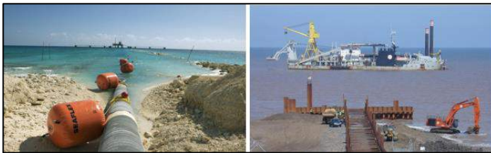
Şekil 9.26. Belwind DRES ENH montajı.
