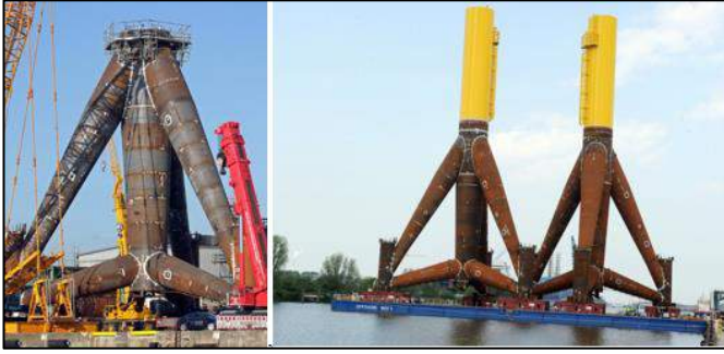
Şekil 10.19. Grup kazıklı temel limanda nakliyeye hazırlanması.
