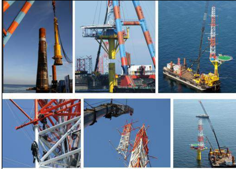
Şekil 4.51. FINO 3 inşaatına ait fotolar.
