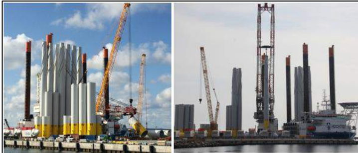
Şekil 10.29. DRT kulenin gemiye yüklenmesi.
