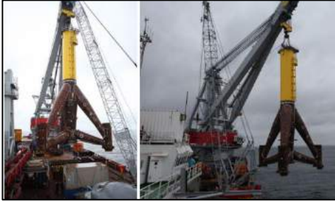
Şekil 10.46. Trianel DRES grup kazıklı temel montajı.
