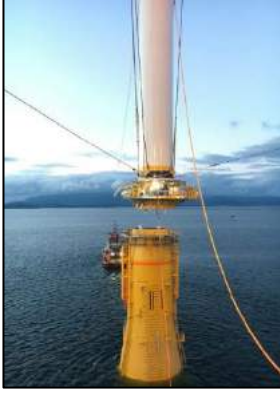
Şekil 10.53. Blyth Scotland DRES kule ilk kısmının geçiş parçasına montajı.
