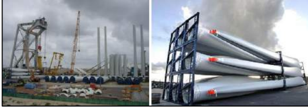
Şekil 11.14. IJMuiden limanındaki malzemelerin depolanması.
