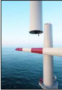
Şekil 10.54. Blyth Scotland DRES kule ilk kısmına ikinci kısmın montajı.
