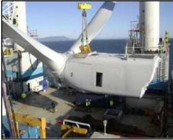
Şekil 10.55. Bunny ear yöntemi.
