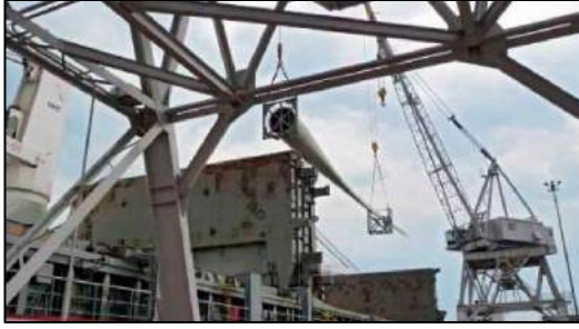
Şekil 6.6. DRT kanadının limanda kaldırılması.
