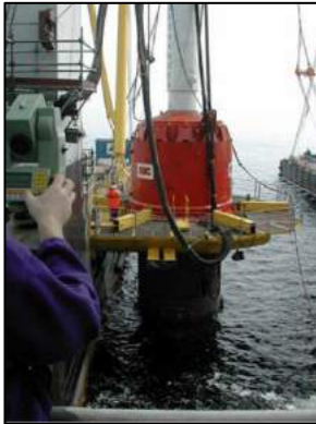
Şekil 11.16. Temelin hidrolik çekiç ile çakılması.
