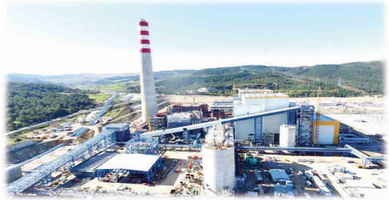
Şekil 34. Kolin Termik Santral İnşaatı- Soma
