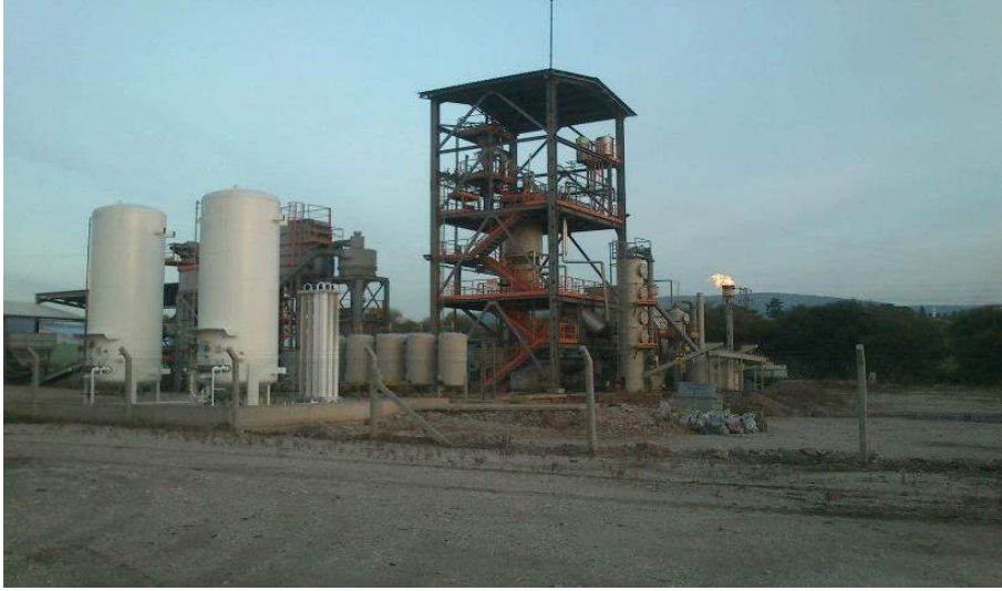
Şekil 5.6 250 t/h Kapasiteli Sürüklemeli Tip Gazlaştırıcı
