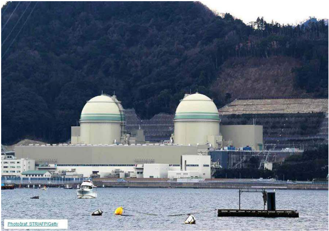
Şekil 9.2.3 Takahama Nükleer Santrali
