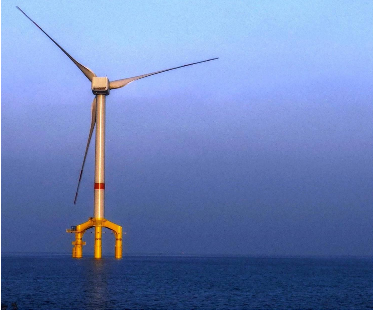
5MW Offshore Türbin- 126 m kanat uzunluğu
