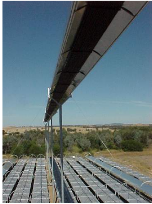
Fresnel tipi kollektör ısı toplama borusu montajı ve tamamlanmış hali (AUSRA Inc.)
