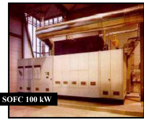
Şekil 2. Yakıt pilli mikro kojenerasyon sistemleri demonstrasyon örnekleri (MCFC: Ergimiş karbonatlı yakıt pili)
