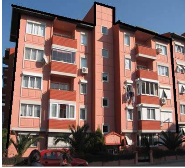
Şekil 1. Seçilen apartman binasının güneybatı (giriş) cephesi
