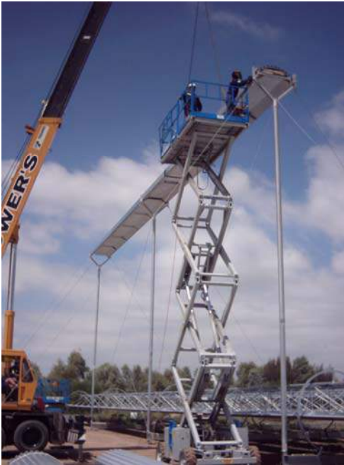
Fresnel tipi kollektör ısı toplama borusu montajı ve tamamlanmış hali (AUSRA Inc.)
